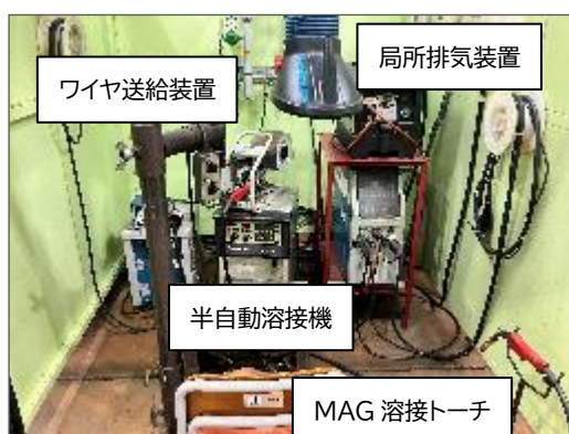
【写真 1】 溶接作業場の全体
